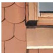
Оклад для плоского кровельного покрытия
